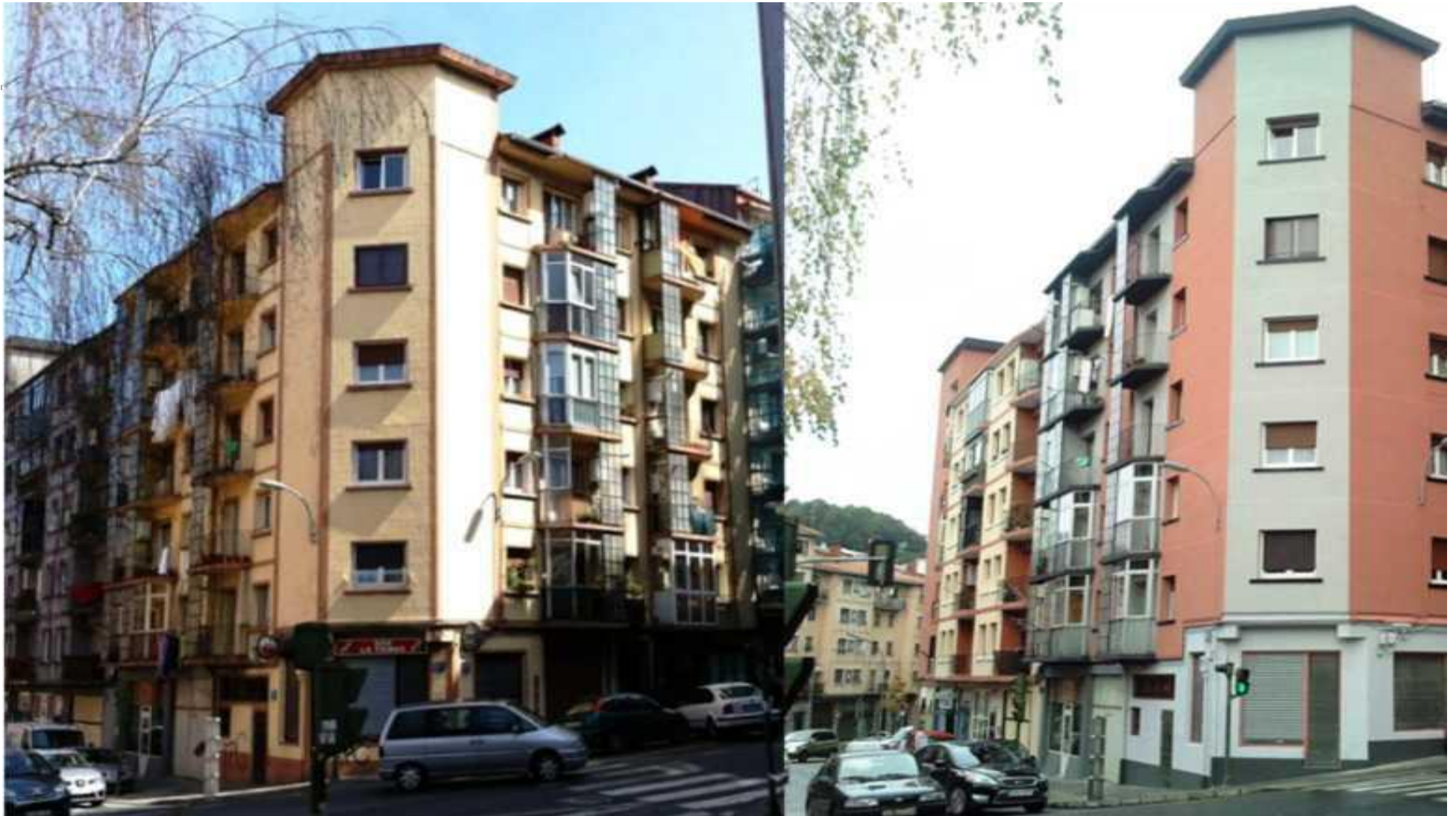
Edificio de viviendas en HERNANI (Guipúzcoa)
